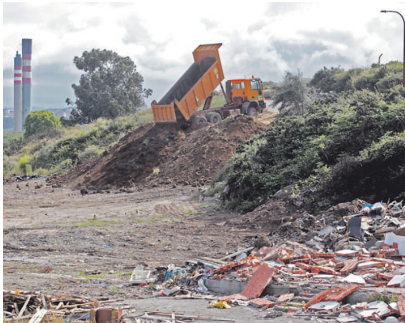
Varios camiones vertieron tierra de cara a la última fase de la regeneración. GUSTAVO RIVAS
